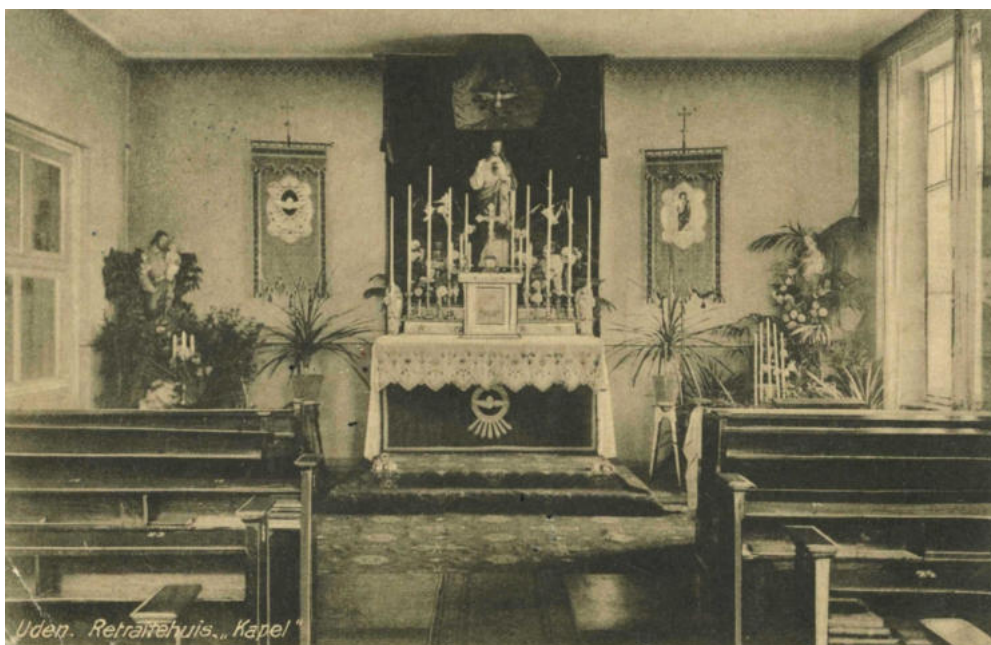
Afb. 20. De kapel op de eerste verdieping.
