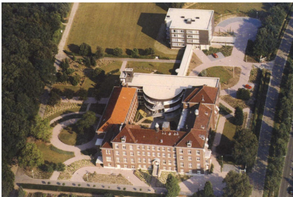
Afb. 60. Luchtfoto van het complex.
