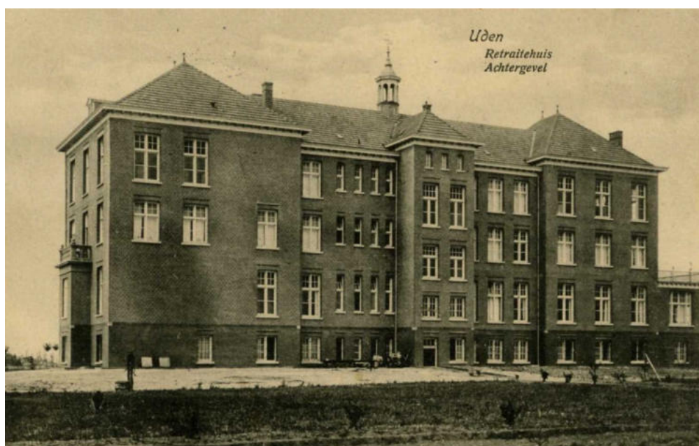
Afb. 19. De achtergevel uit 1913. Links, achter de blinde muur, lag de kapel.
