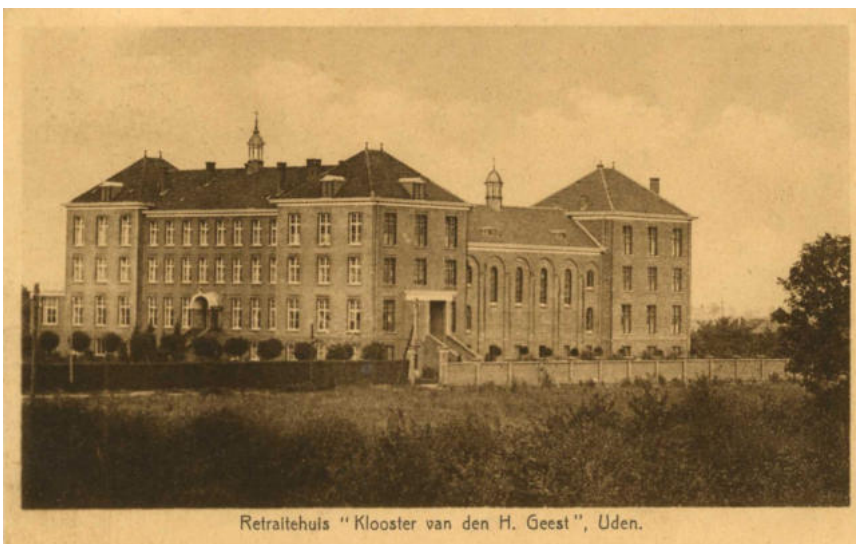
Afb. 23. Bij de uitbreiding van 1923 kwam de nieuwe hoofdingang te liggen op de plaats van de oude kapel. In de nieuwe vleugel kwam o.a. een royale nieuwe kapel.
